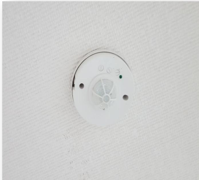
*Figura 5.3 Sensor de presencia infrarrojo*
