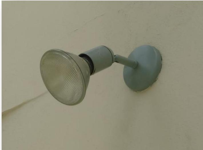
*Figura 3.13 Lámpara incandescente halógena*
