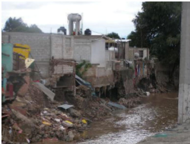
Figura 2.2: Viviendas dañadas por el huracán Dean [36].
