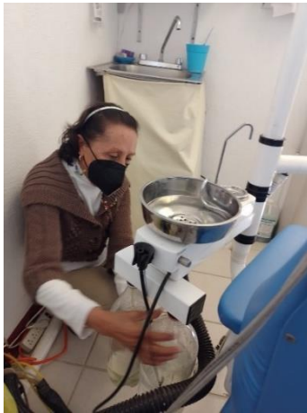
Mantenimiento de unidad
