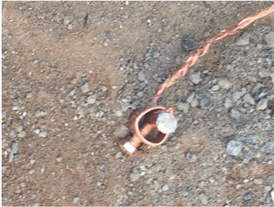
Ilustración 4-17 Instalación tierra física
