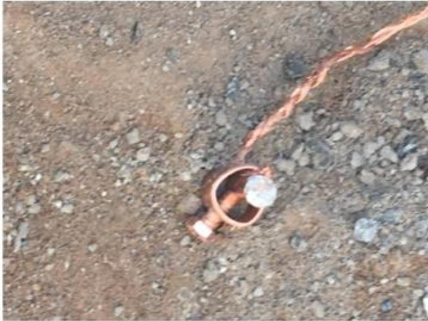
Ilustración 4-17 Instalación tierra física
