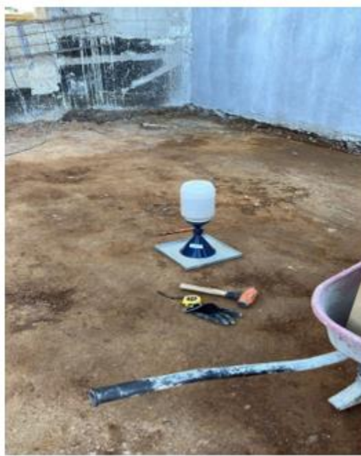
Ilustración 6 Prueba de Compactación 2
