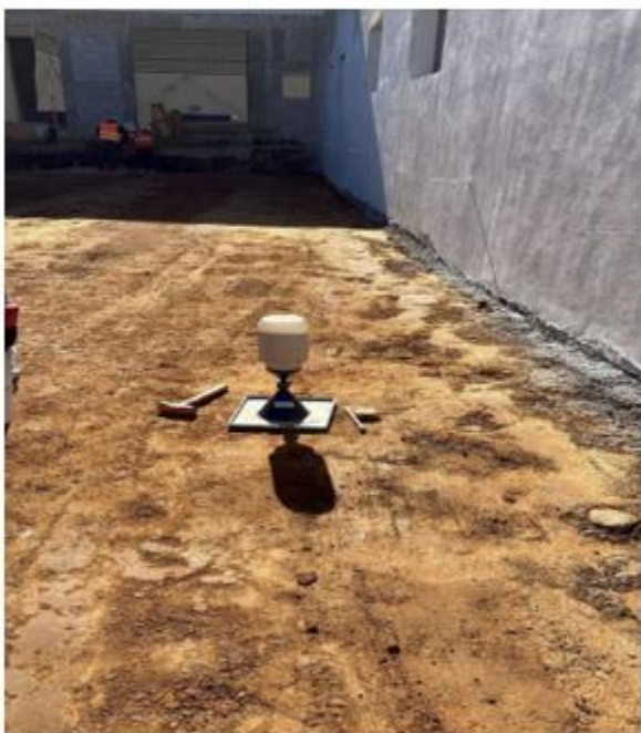
Ilustración 5 Prueba de Compactación
