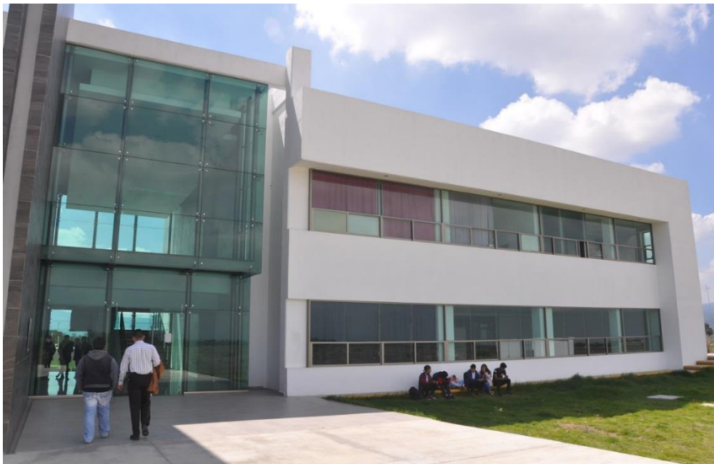
Foto 9. Edificio de docencia "C".
